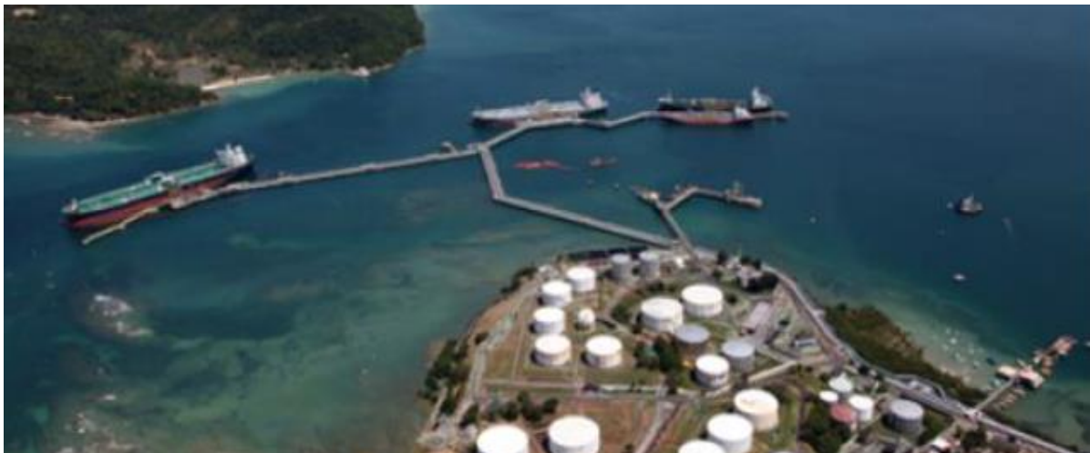
Figura 6- Terminal Marítimo TEMADRE
